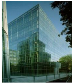
شكل (١٩) الغلاف الخارجى المزدوج للمبنى ويظهر الزجاج المصفح الملون.
