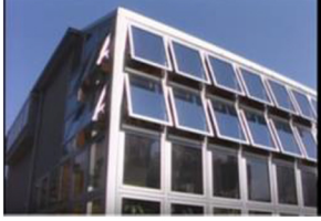
شكل (٤) كاسرات شمسية زجاجية متحركة طبقاً لكمية الضوء المطلوبة لتحقيق الراحة بالفراغ ١٢ .
