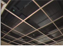
شكل (٥) تبريد السطح خلف الاسقف المعلقة ١٢ .
