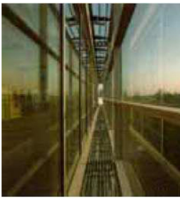
شكل (١٩) الغلاف الخارجى المزدوج للمبنى ويظهر الزجاج المصفح الملون.
