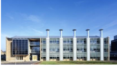
شكل (٣١) واجهة المبنى البيئي بإنجلترا BRE ٤٥ .
