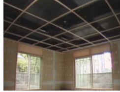
شكل (٥) تبريد السطح خلف الاسقف المعلقة ١٢ .
