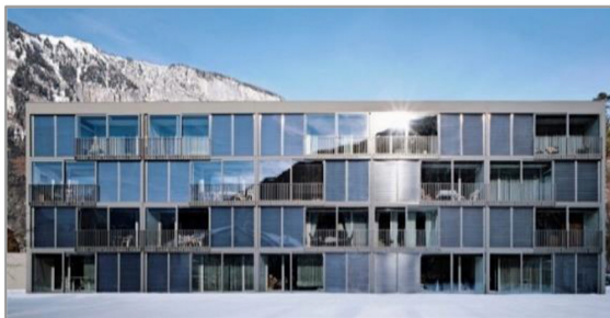
شكل (١٧) واجهة مبنى " Sur Falveng " حيث تظهر تغطية الواجهة بالزجاج متغير الطور {١١} .
