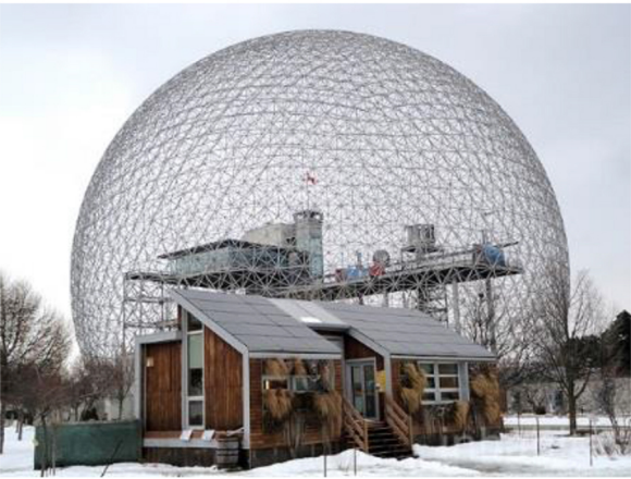
شكل ٦ استخدام التنظيم الشبكي في القبة الجيوديسية لبكمينستر فولر (Buckminster Fuller)، والمصدر: http://inhabitat.com
