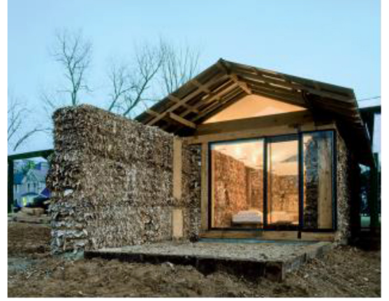
شكل (٢) مشروع إسكان تجريبي لطلبة جامعة أوبورن (Auburn University) بالولايات المتحدة الأمريكية ٢٠ نتيجة للإحتكاك الناتج عن إرتفاع الوزن و خشونة السطح فليس هناك حاجة لدعم إضافي أي تعزيزات.
