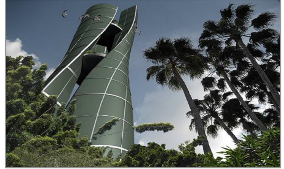
شكل (٢٣) الواجهه الخارجية لمبنى غلاف النانو {٣٠}.
